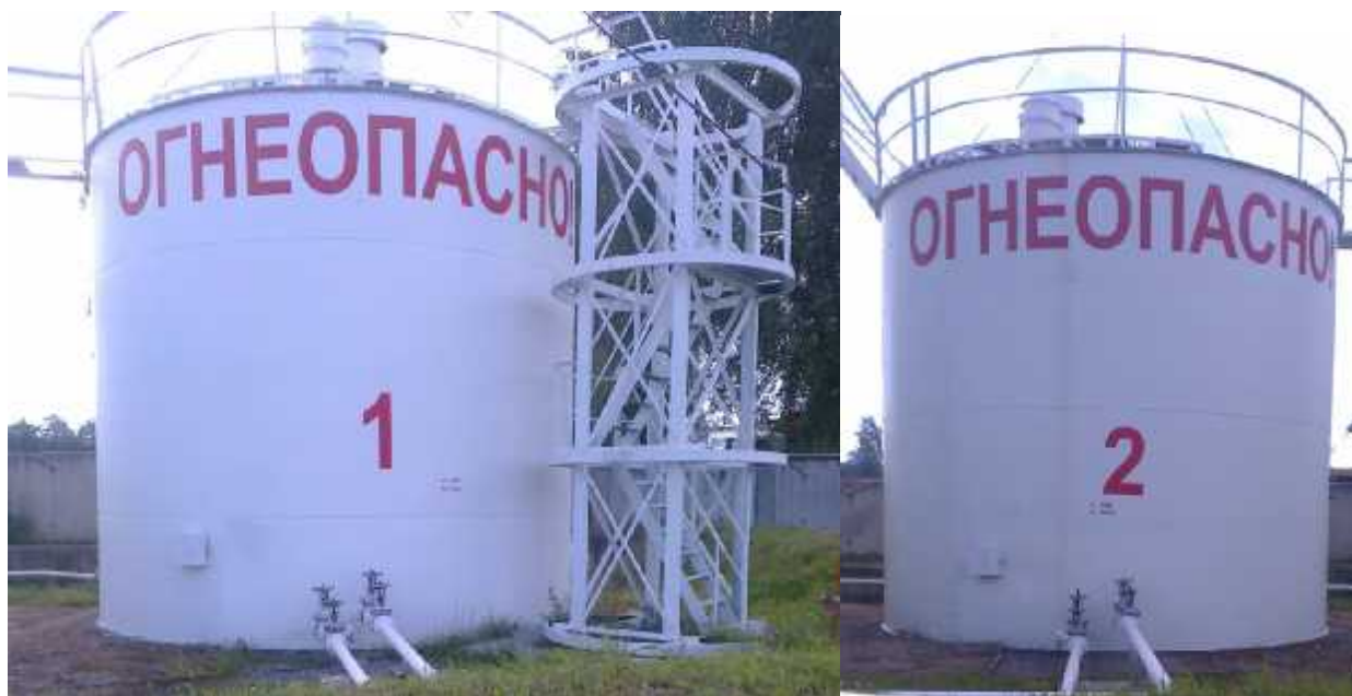
Рисунок 1 - Общий вид РВС-200, заводские номера 1,2
