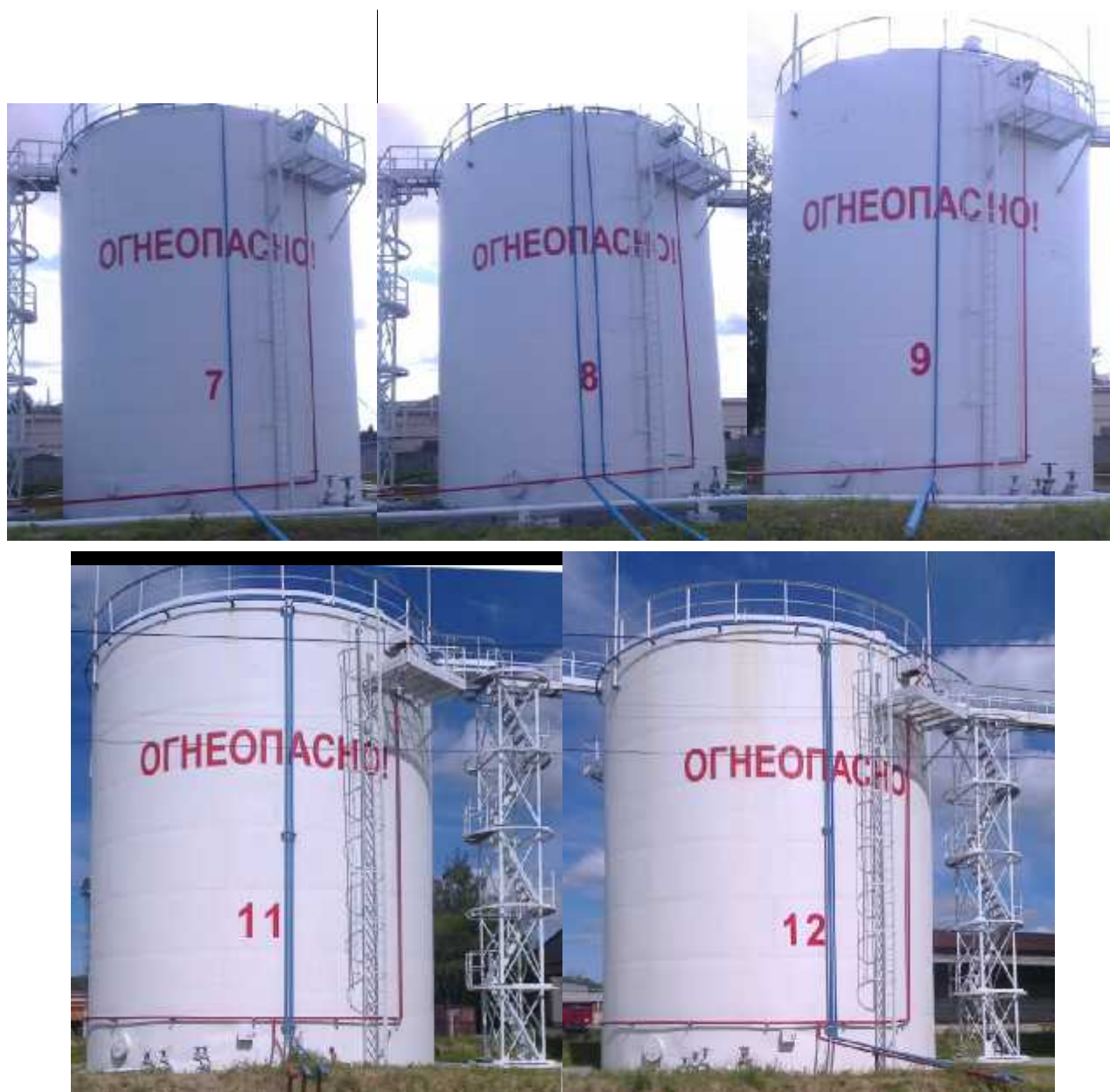
Рисунок 3 - Общий вид РВС-1000, заводские номера 7, 8, 9, 11, 12
