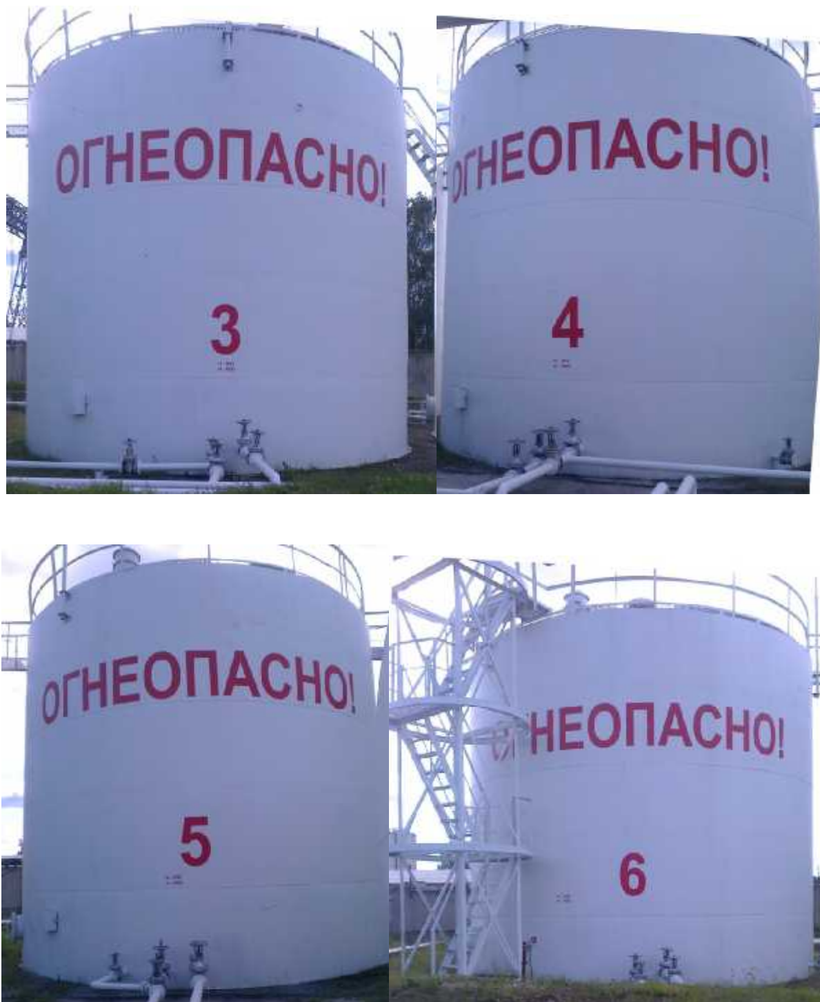
Рисунок 2 - Общий вид РВС-400, заводские номера 3, 4, 5, 6
