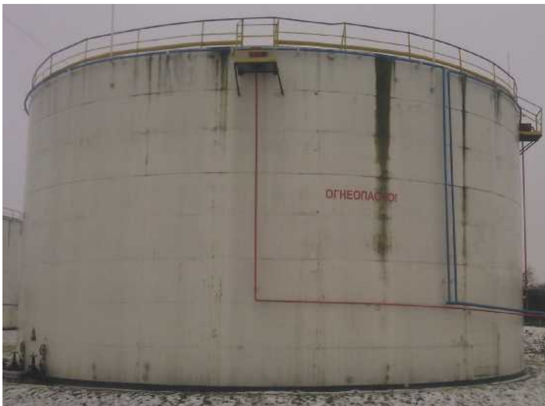
Рисунок 2 - Общий вид резервуара стального вертикального цилиндрического РВС-5000
