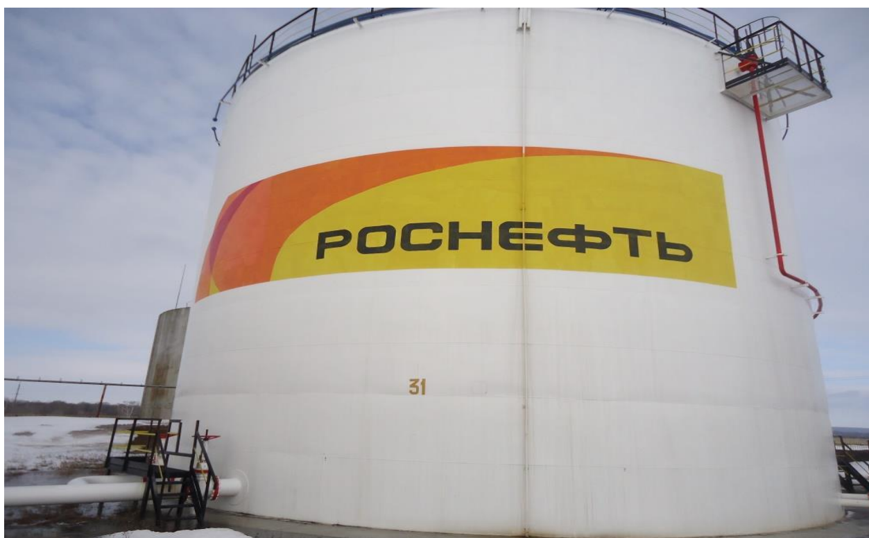
Рисунок 5 - Общий вид резервуара стального вертикального цилиндрического РВС-5000
