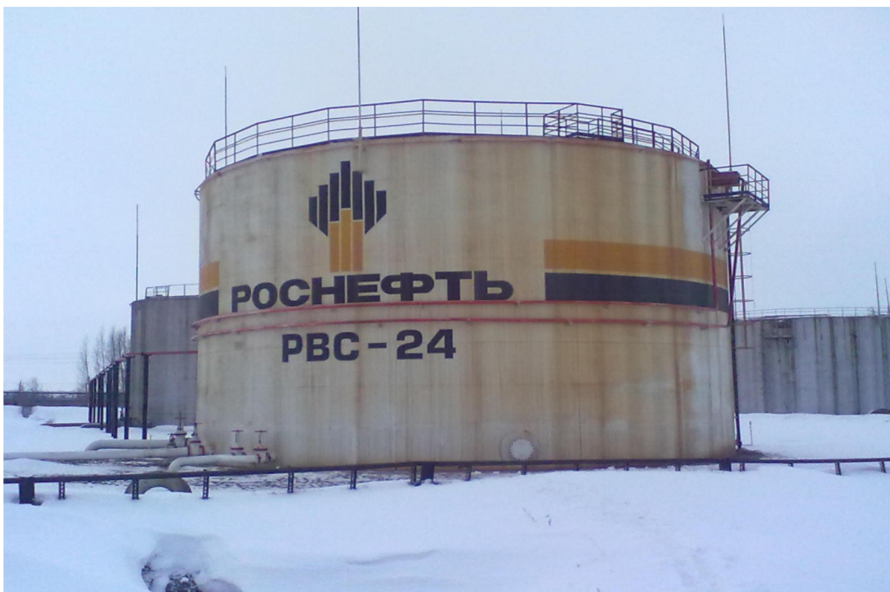
Рисунок 4 - Общий вид резервуара стального вертикального цилиндрического РВС-4000
