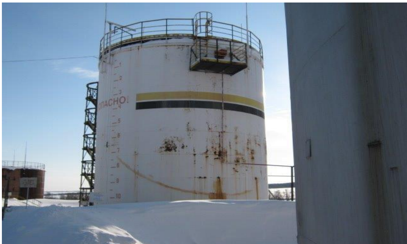
Рисунок 1 - Общий вид резервуара стального вертикального цилиндрического РВС-1000
