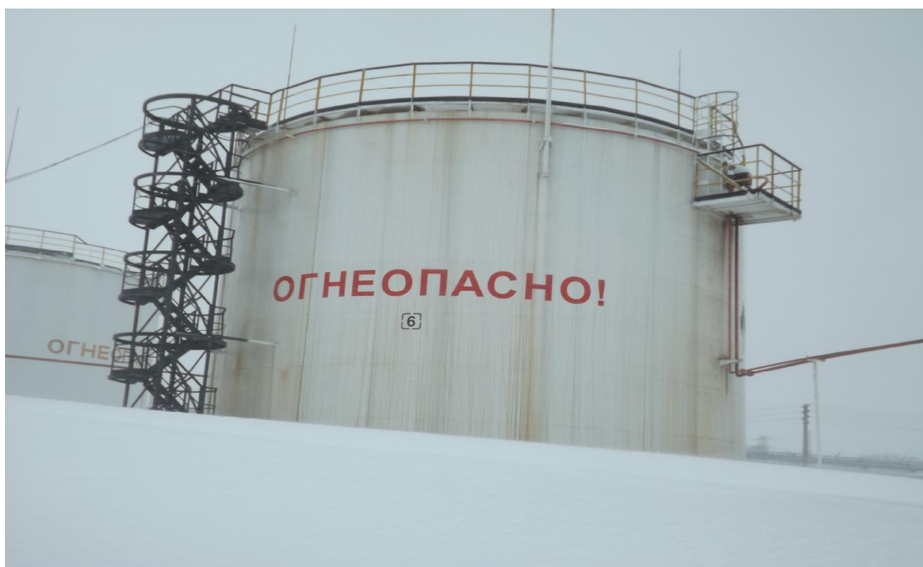
Рисунок 2 - Общий вид резервуара стального вертикального цилиндрического РВС-2000
