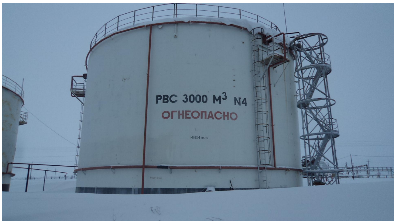
Рисунок 3 - Общий вид резервуара стального вертикального цилиндрического РВС-3000
