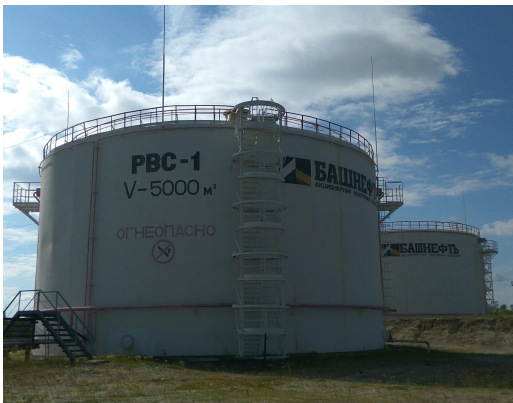
Рисунок 1. Общий вид резервуара РВС-5000
