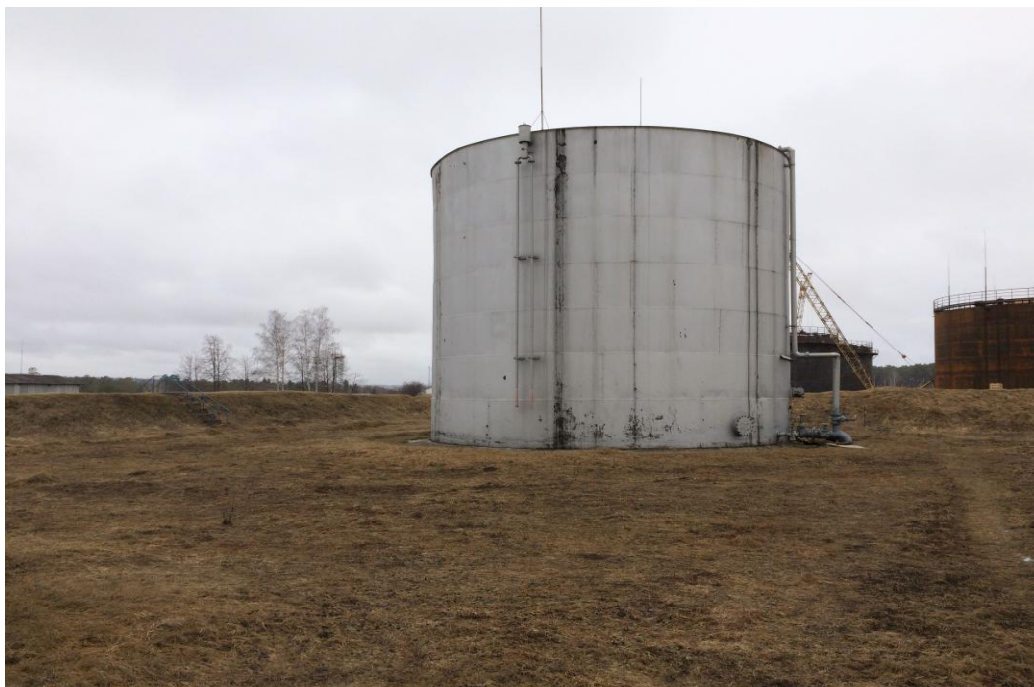
Рисунок 1 – Общий вид резервуара РВС-400
