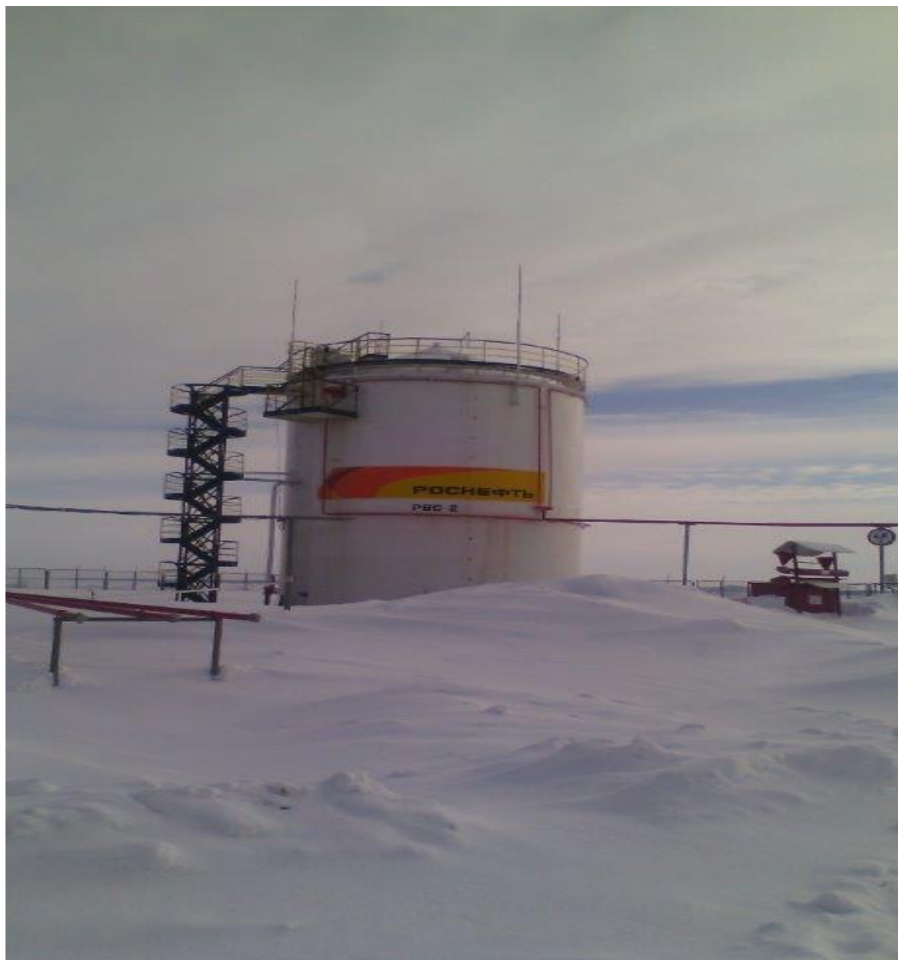
Рисунок 1 - Общий вид резервуара стального вертикального цилиндрического РВС-1000
