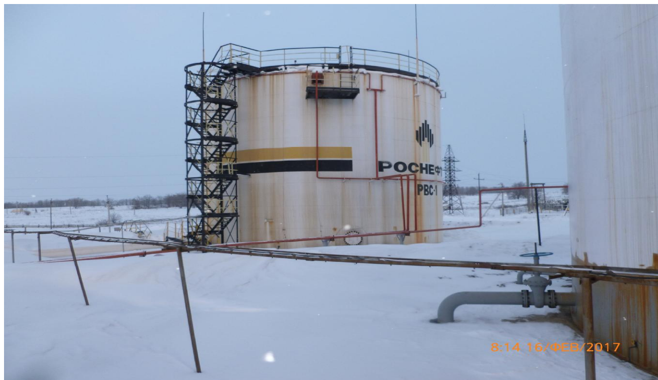
Рисунок 2 - Общий вид резервуара стального вертикального цилиндрического РВС-2000
