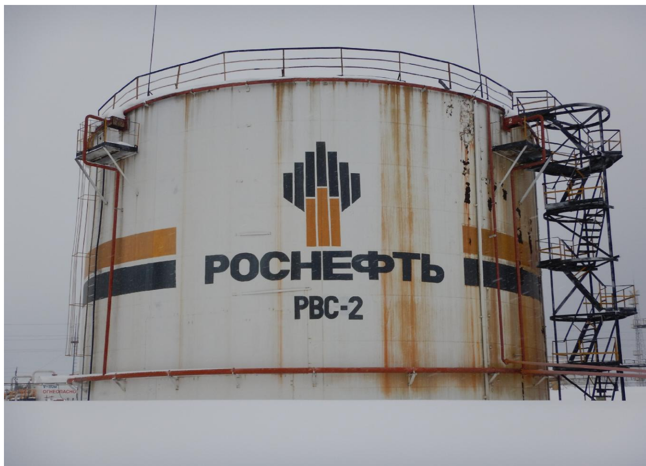
Рисунок 3 - Общий вид резервуара стального вертикального цилиндрического РВС-3000
