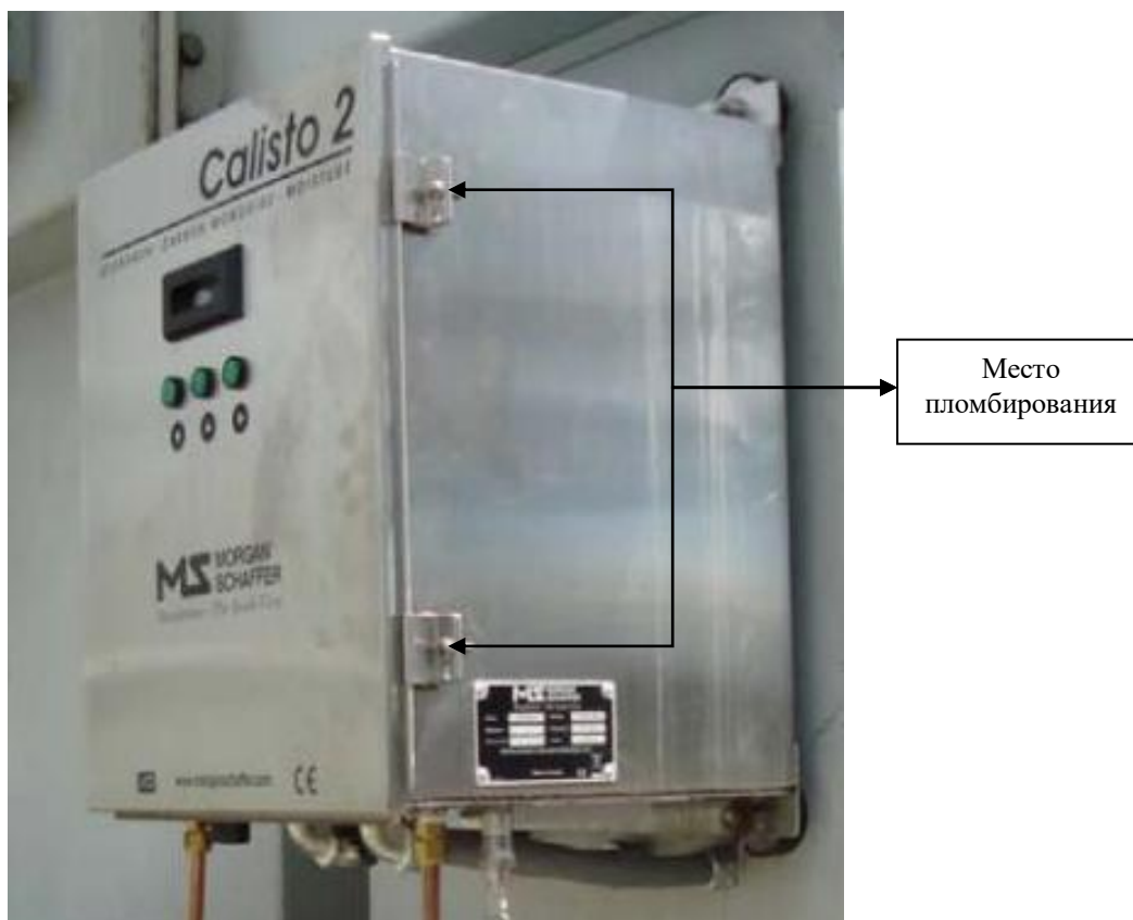
Рисунок 1 – Общий вид и схема пломбирования от несанкционированного доступа анализаторов трансформаторного масла Calisto
