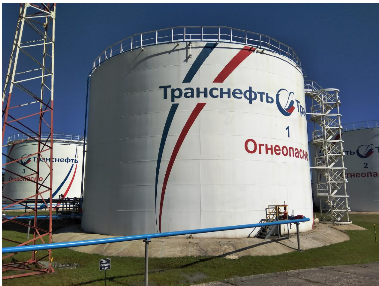
Рисунок 1 - Общий вид резервуара вертикального стального цилиндрического РВС-3000
