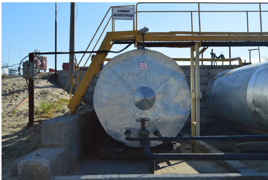
Рисунок 1 – Общий вид резервуара РГС-50
