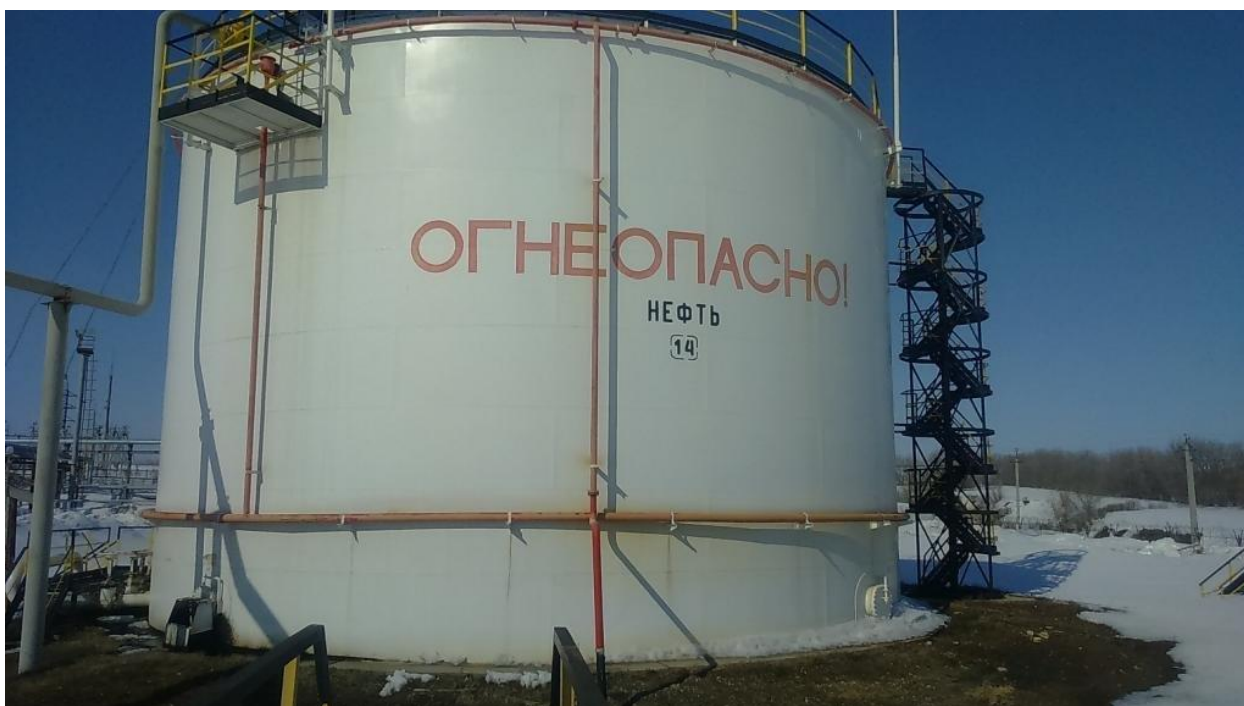
Рисунок 2 - Общий вид резервуара стального вертикального цилиндрического РВС-3000
