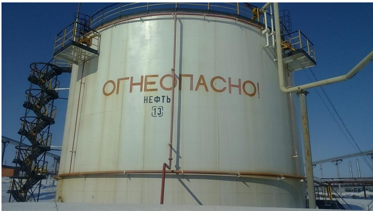
Рисунок 1 - Общий вид резервуара стального вертикального цилиндрического РВС-3000
