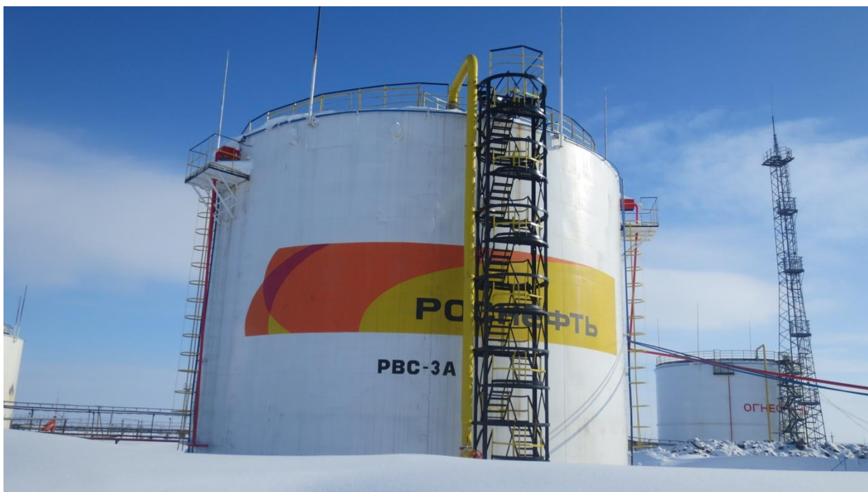
Рисунок 2 - Общий вид резервуара стального вертикального цилиндрического РВС-5000
