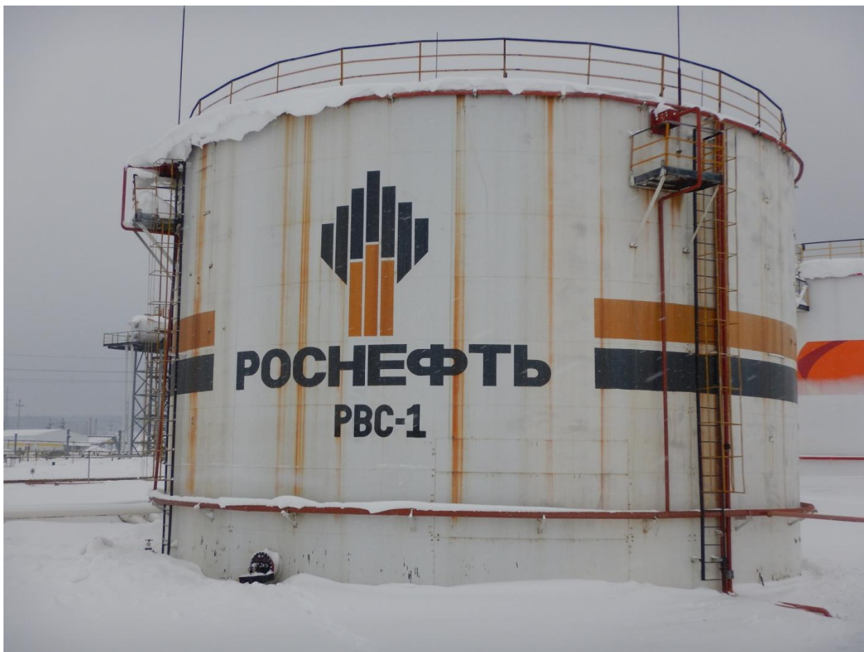
Рисунок 1 - Общий вид резервуара стального вертикального цилиндрического РВС-3000
