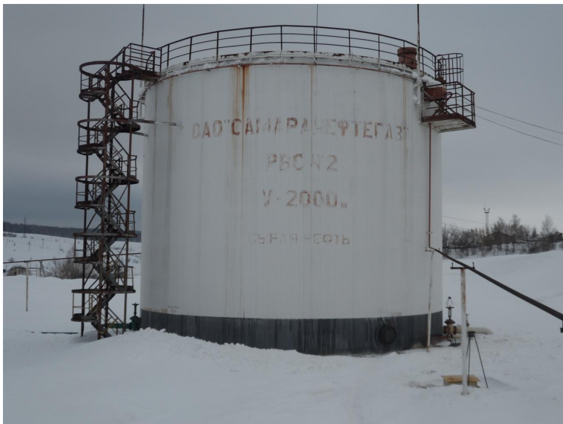
Рисунок 1 - Общий вид резервуара стального вертикального цилиндрического РВС-2000
