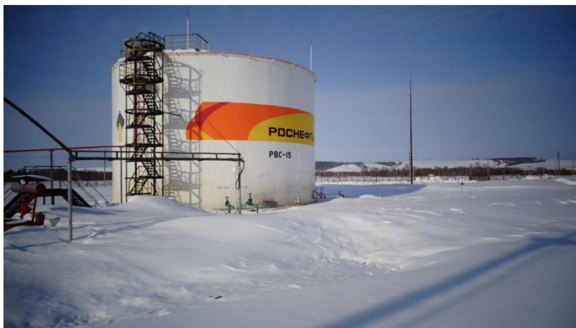
Рисунок 2 - Общий вид резервуара стального вертикального цилиндрического РВС-3000
