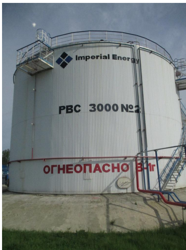
Рисунок 1 - Общий вид резервуара
