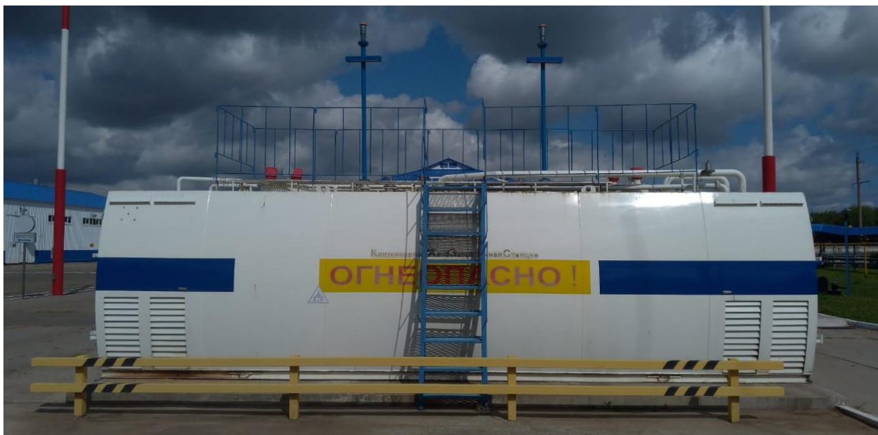
Рисунок 1 – Общий вид резервуаров РГС-16
