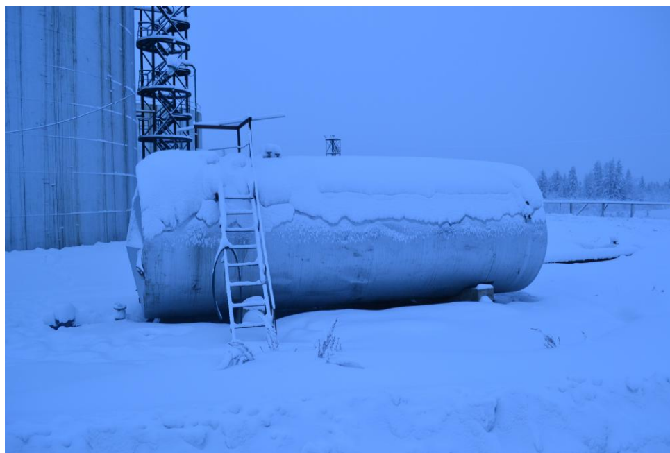
Рисунок 1 - Общий вид резервуара РГС-50
