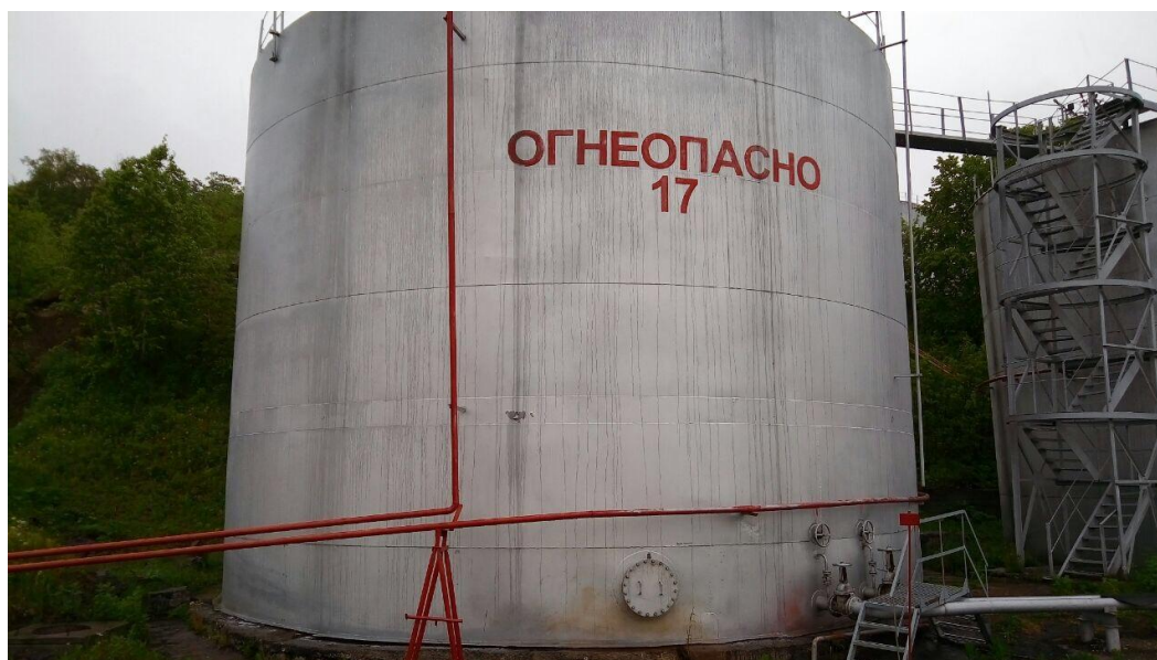
Рисунок 1 - Общий вид резервуара РВС-1000
