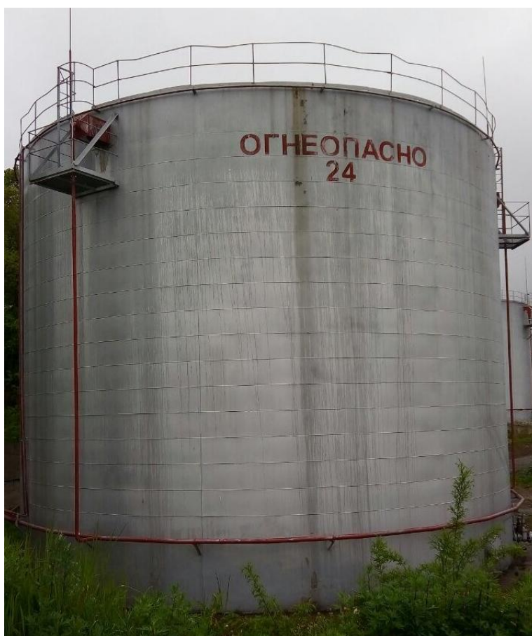
Рисунок 2 - Общий вид резервуара РВС-2000
