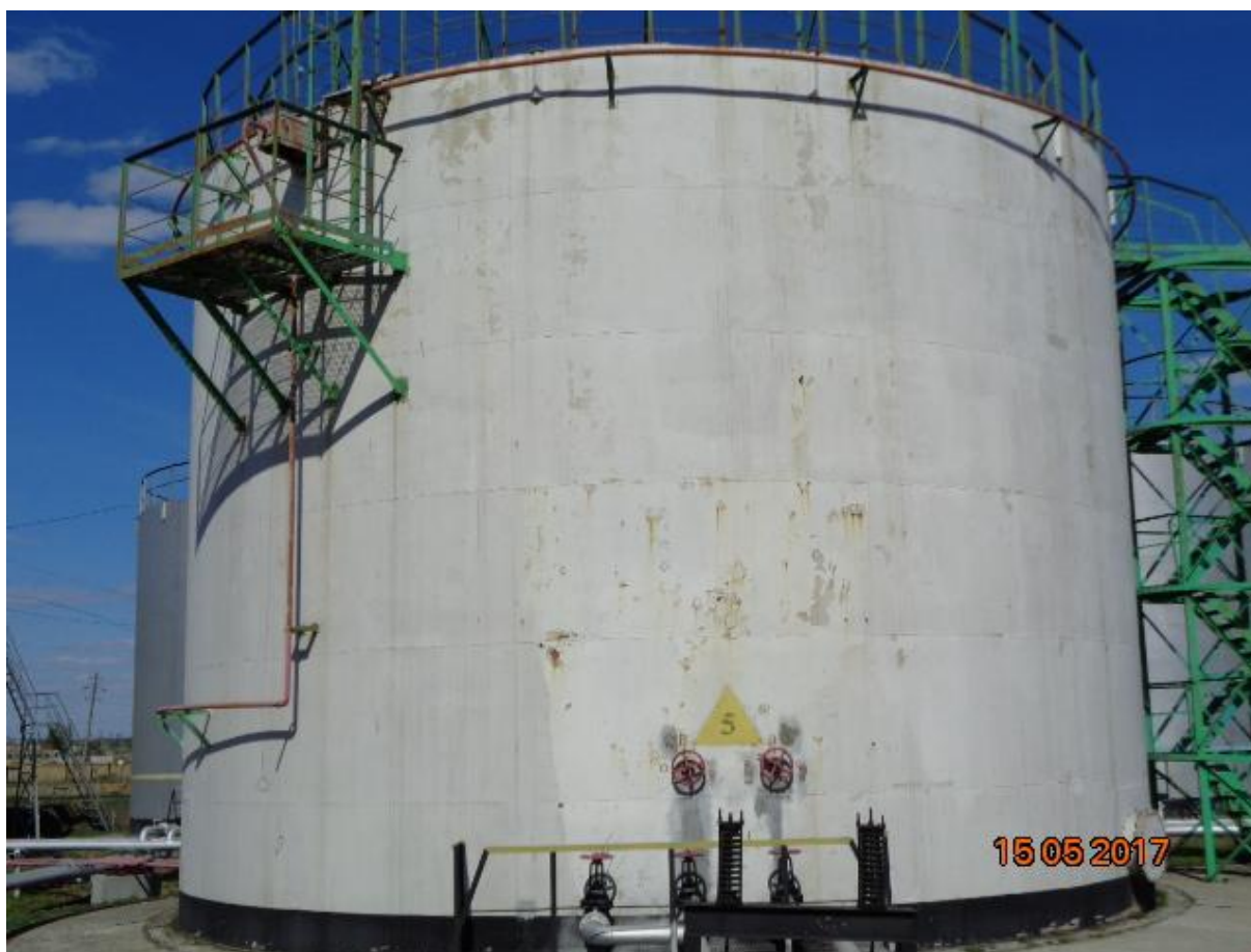
Рисунок 1 - Общий вид резервуара вертикального стального цилиндрического РВС-1000
