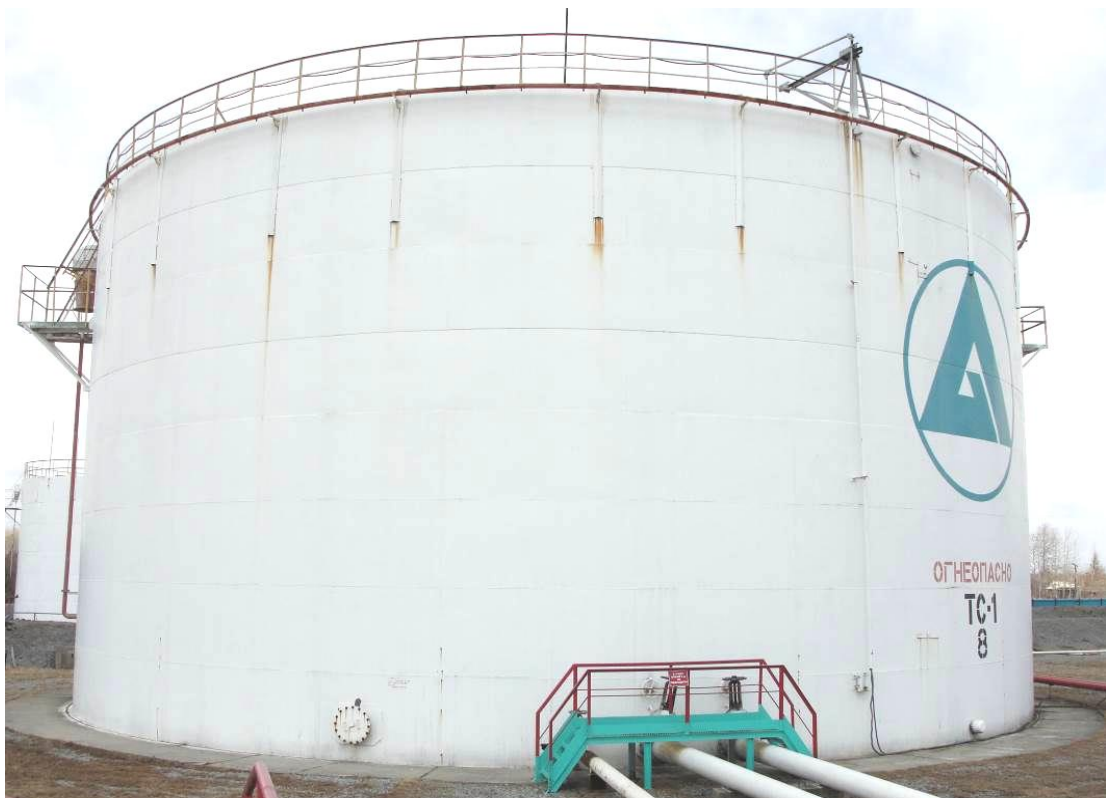
Рисунок 1 - Общий вид резервуара РВС-5000
