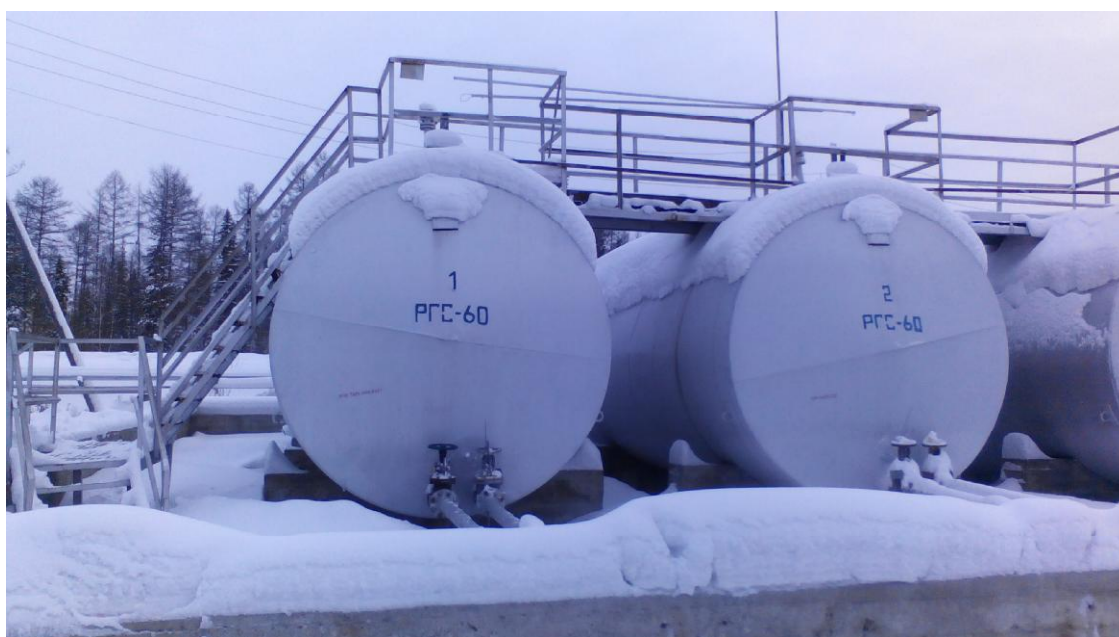
Рисунок 1 - Общий вид резервуара РГС-60
