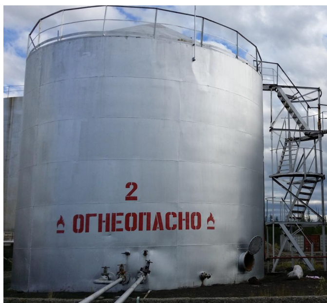
Рисунок 2 - Общий вид резервуара РВС-400
