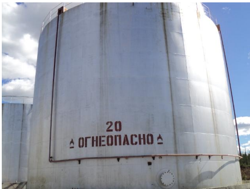
Рисунок 4 - Общий вид резервуара РВС-2000
