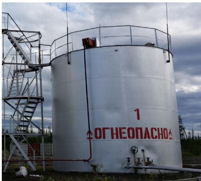
Рисунок 1 - Общий вид резервуара РВС-200
