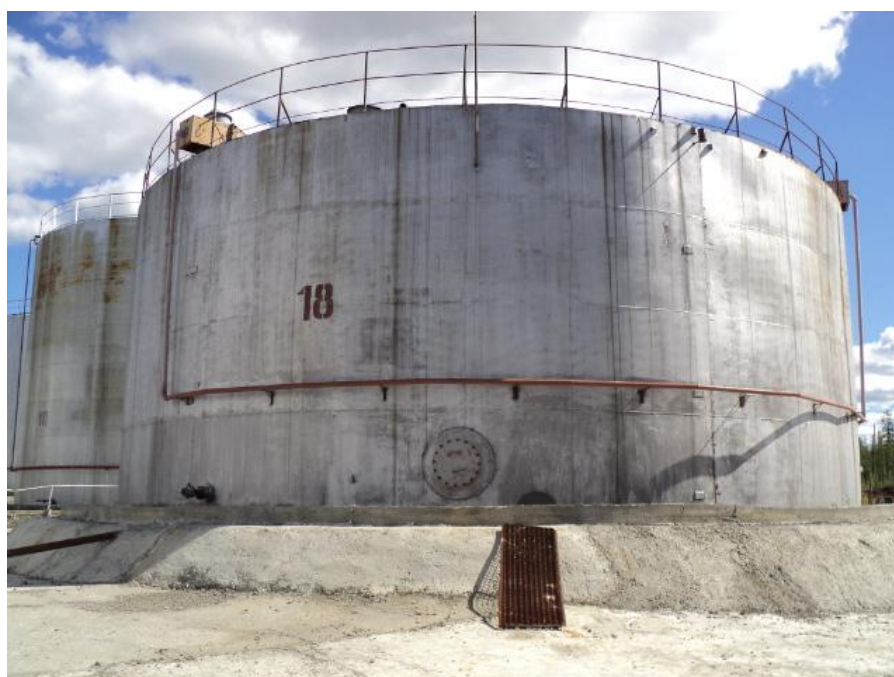
Рисунок 3 - Общий вид резервуара РВС-1000
