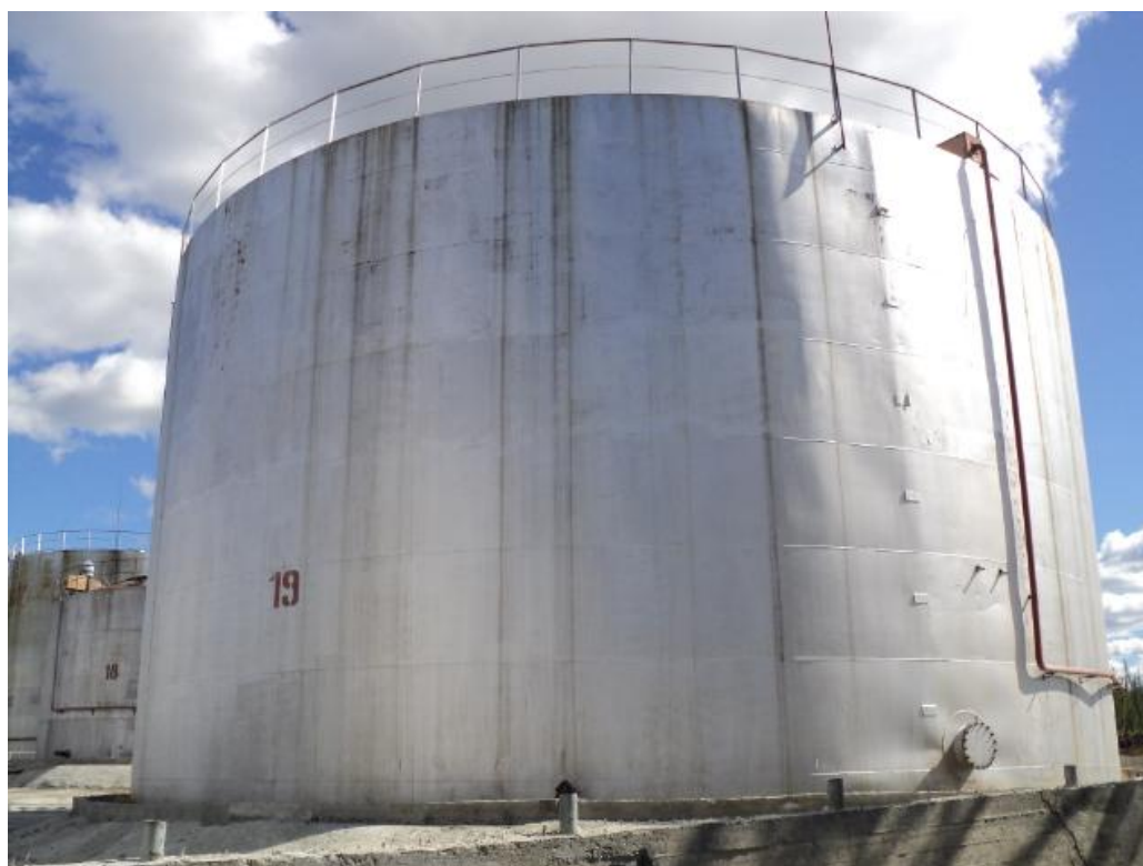
Рисунок 5 - Общий вид резервуара РВС-3000
