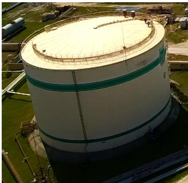
Рисунок 1- Общий вид резервуара РВС-10000
