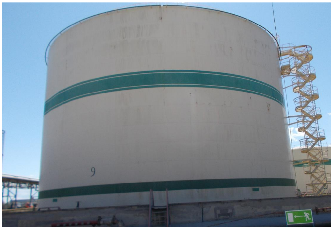
Рисунок 1 - Общий вид резервуара стального вертикального цилиндрического РВС-10000
