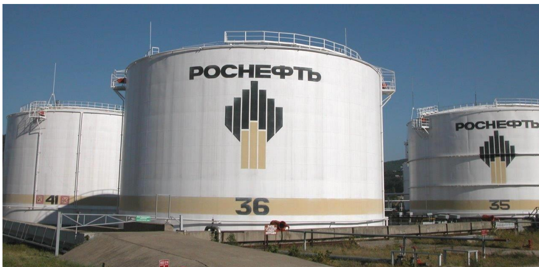
Рисунок 1 - Общий вид резервуаров
