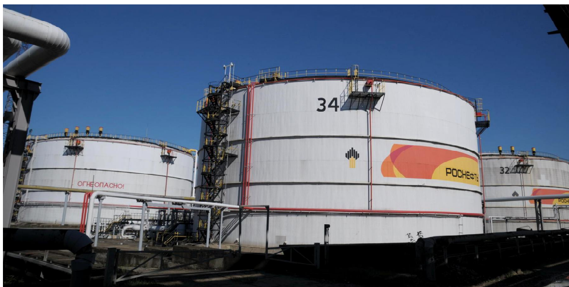
Рисунок 1 - Общий вид резервуаров
