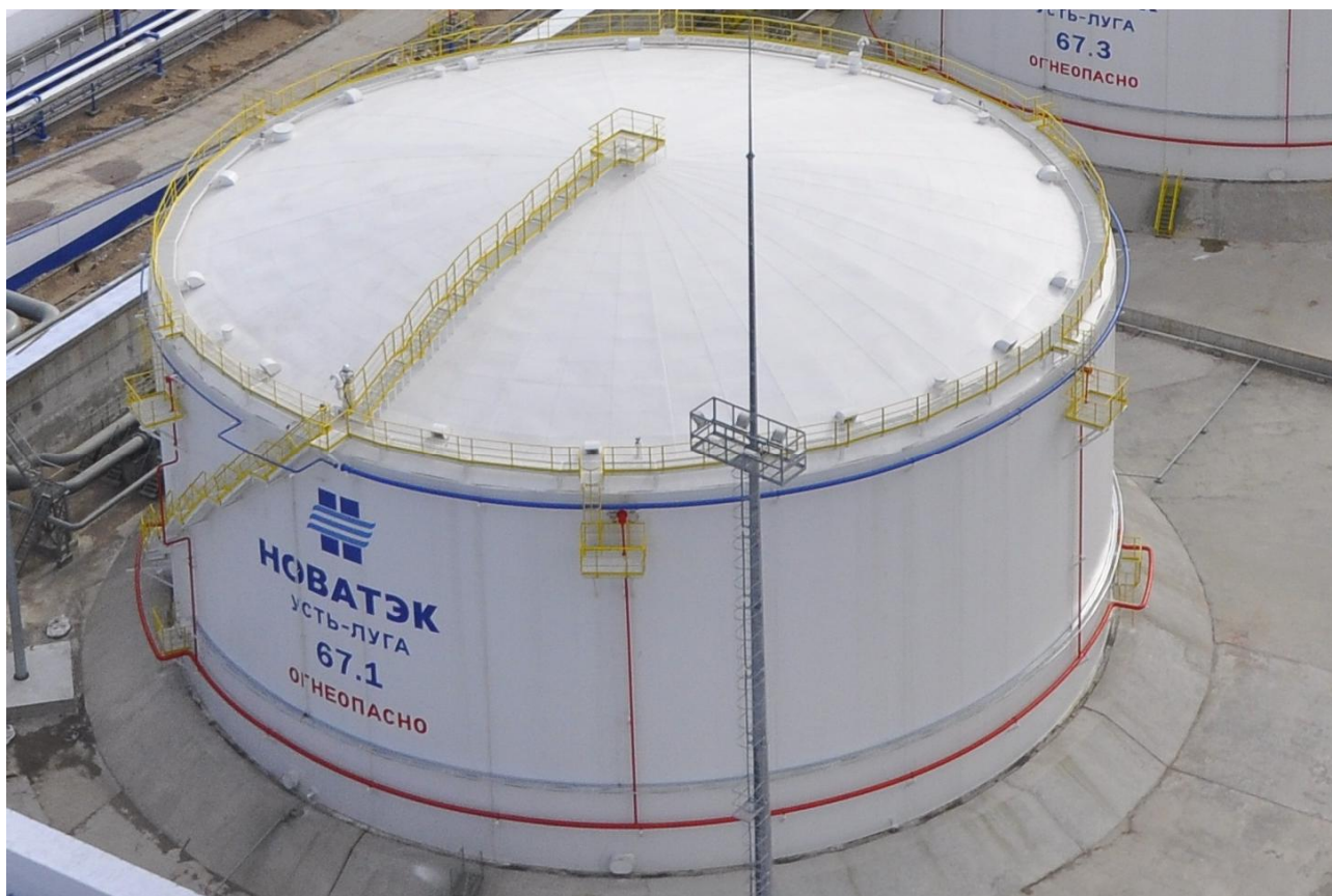
Рисунок 1 - Общий вид резервуара стального вертикального с понтоном РВСП-30000
