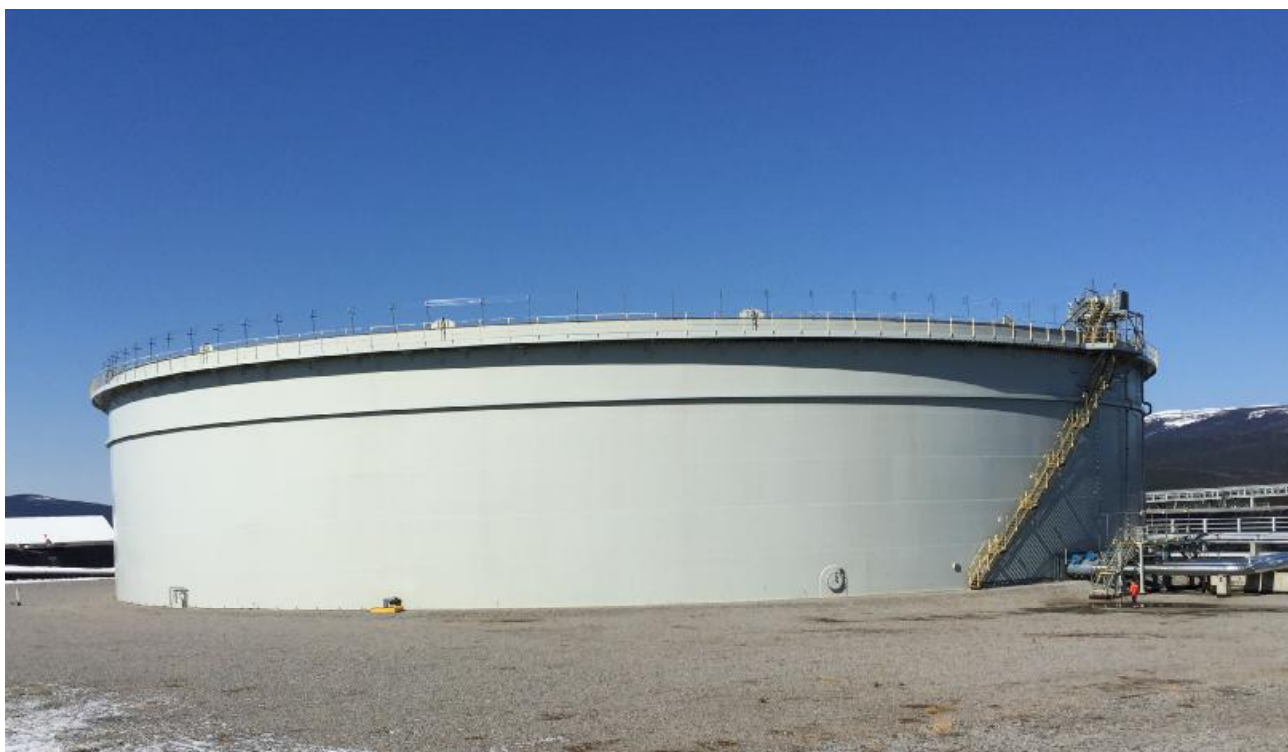
Рисунок 1 – Общий вид резервуара стального вертикального цилиндрического с плавающей крышей РВСПК-100000
