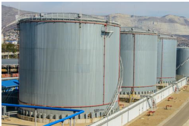
Рисунок 1 – Общий вид резервуара
