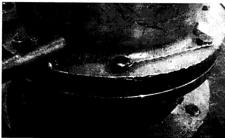
Рисунок 1 – Место пломбировки датчика от несанкционированного доступа.
