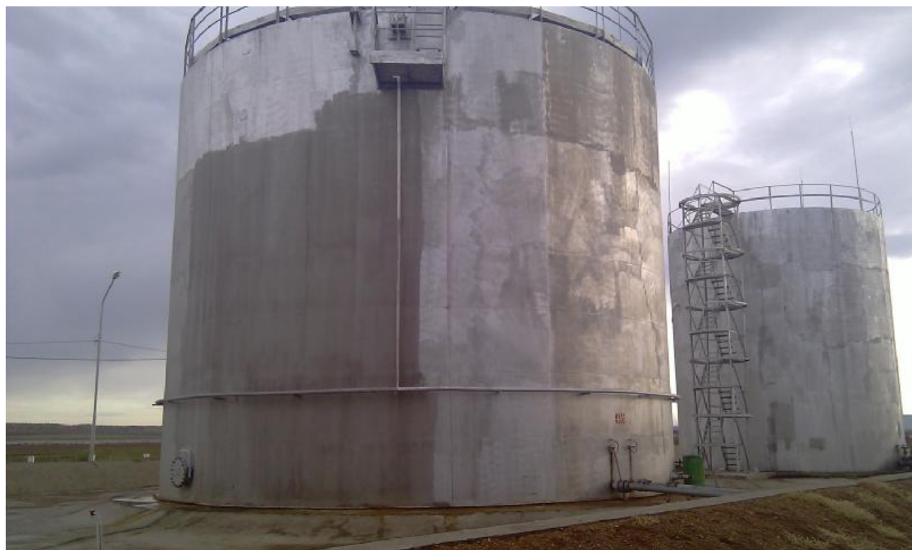
Рисунок 1 – Общий вид резервуара
