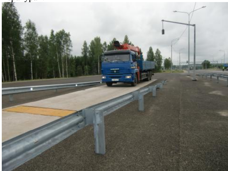
Рисунок 1- Общий вид весов автоматических для взвешивания транспортных средств в движении и измерения нагрузок на оси SUPAWEIGH 5000c
