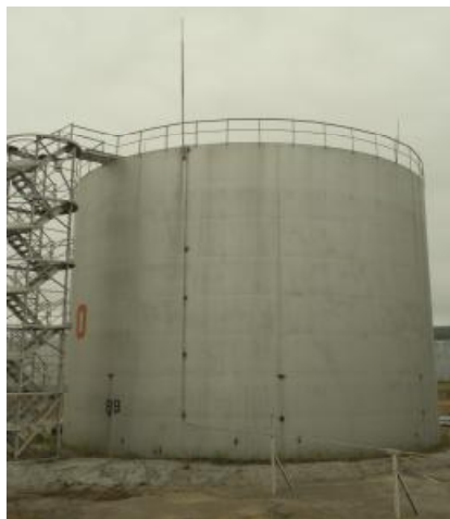
Рисунок 1 – Общий вид резервуара
