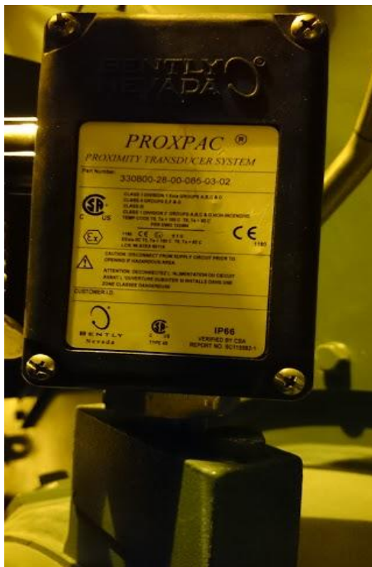
Рисунок 1 - Внешний вид датчика перемещения VN-330800-28-00-085-03-02
