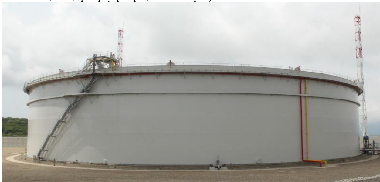
Рисунок 1 - Общий вид резервуара
