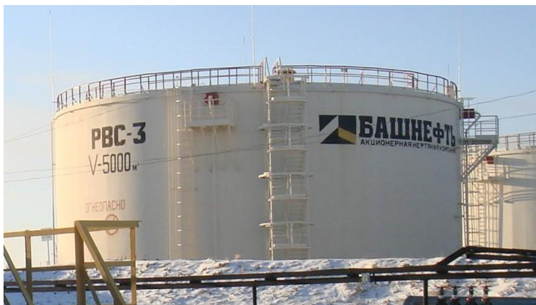
Рисунок 1 – Общий вид резервуаров стальных вертикальных цилиндрических РВСП-5000
