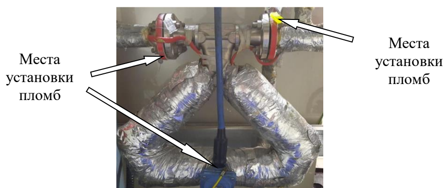
Рисунок 2 – Схема пломбировки от несанкционированного доступа счетчика-расходомера массового Micro Motion модели CMF100 с измерительным преобразователем RFT9739**
