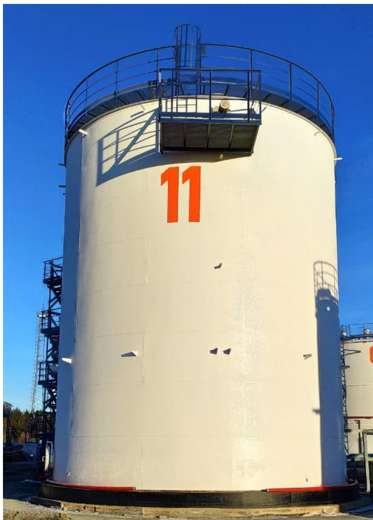
Рисунок 1 – Общий вид резервуаров РВС-1000
