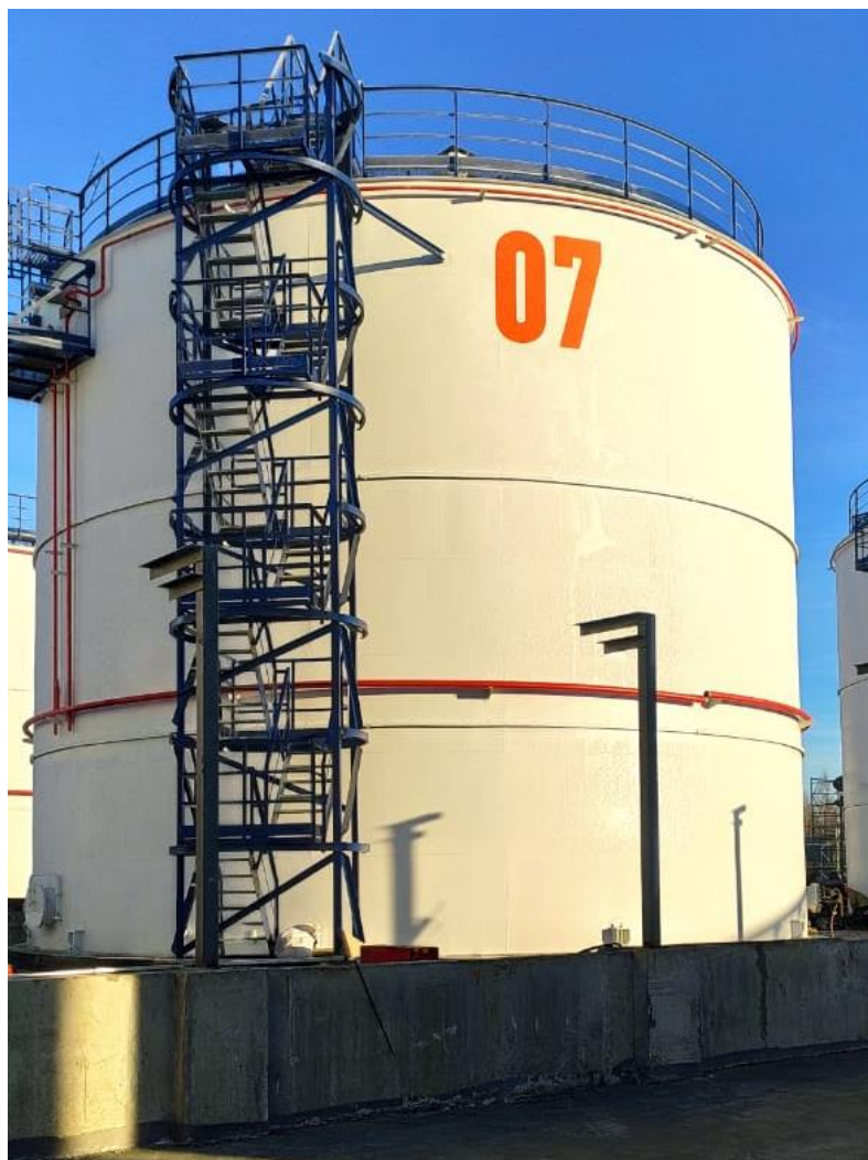
Рисунок 1 – Общий вид резервуаров РВС-2000
