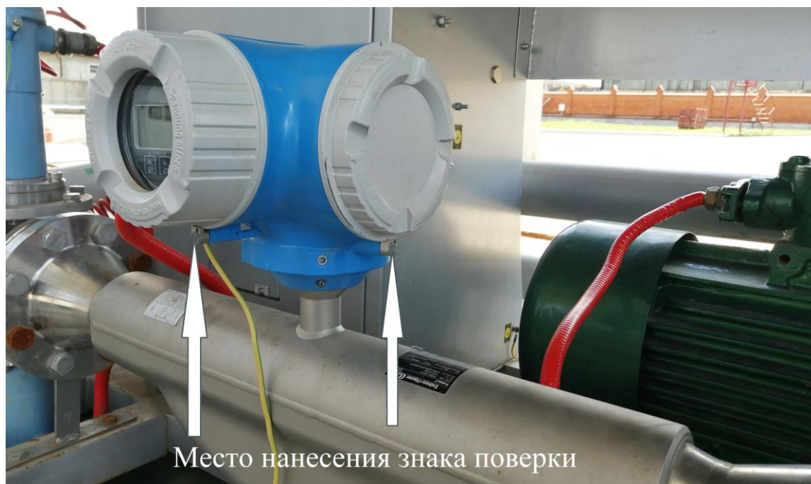
Рисунок 2 – Схема пломбировки электронного блока расходомера массового Promass
