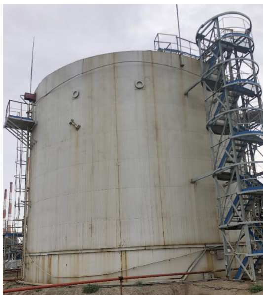
Рисунок 1 – Общий вид резервуара РВСП-2000 зав. №№ Е-309, Е-310, Е-311
