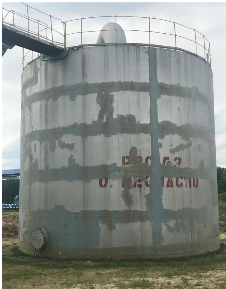
Рисунок 1 – Общий вид резервуара РВС-400
