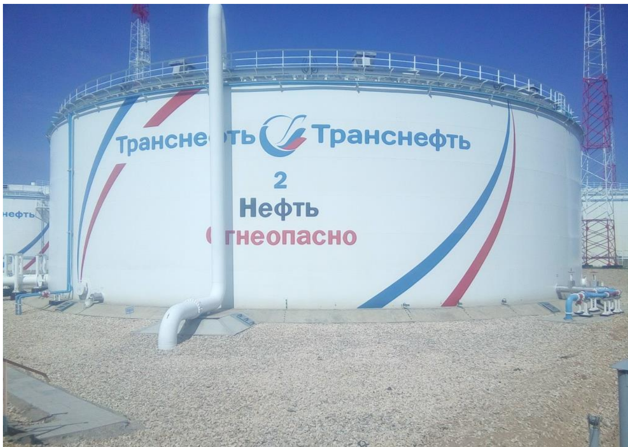
Рисунок 1 – Общий вид резервуара РВС-20000
