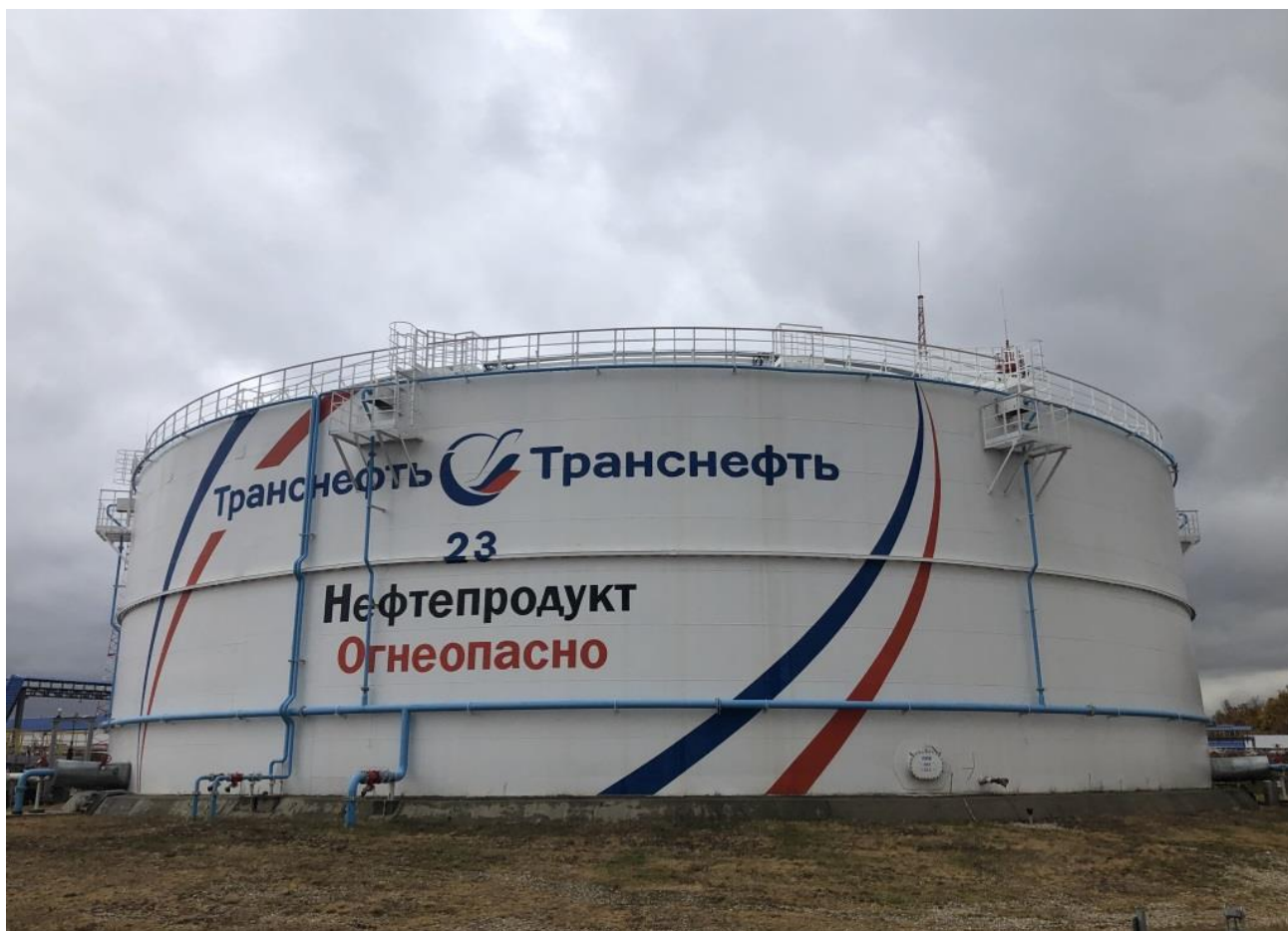
Рисунок 1 – Общий вид резервуара РВС-20000
