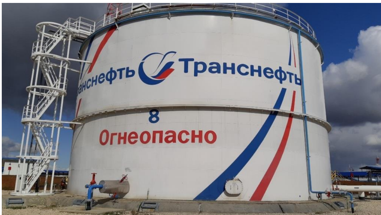
Рисунок 1 – Общий вид резервуара РВС-5000
