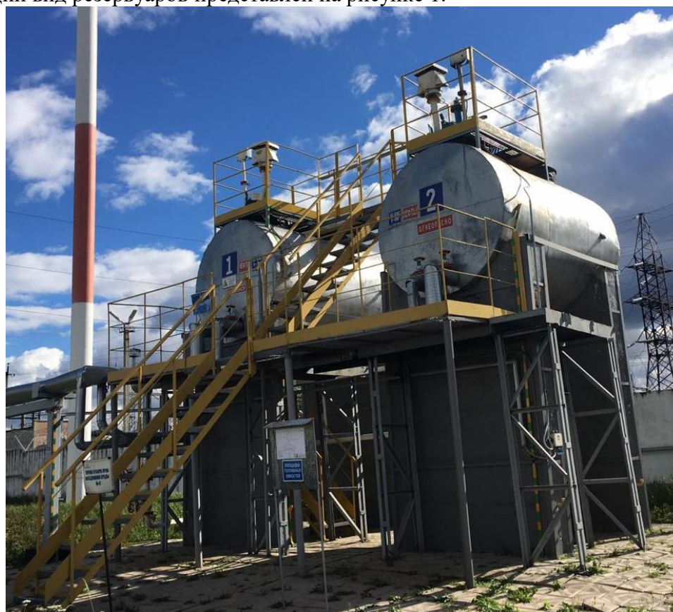
Рисунок 1 – Общий вид резервуаров
