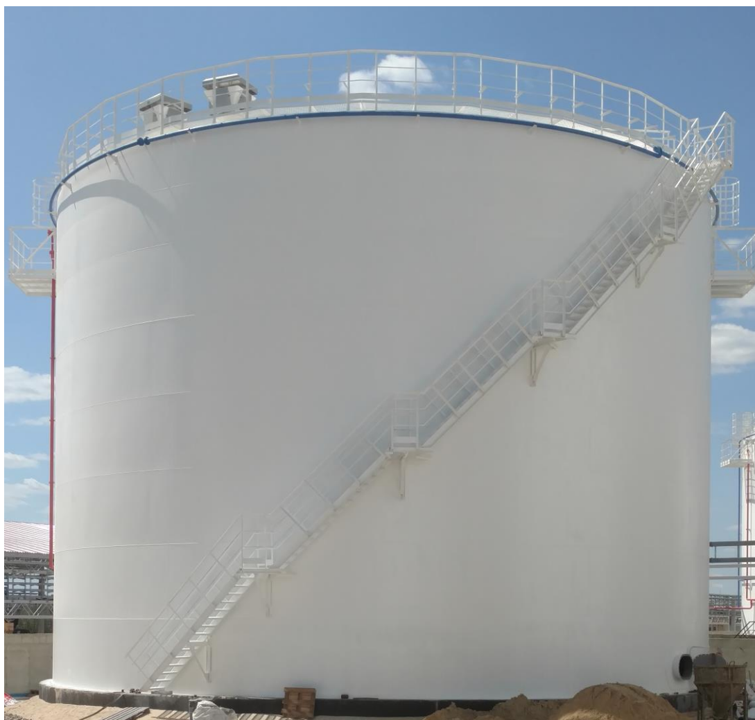
Рисунок 1. Общий вид резервуара РВС-5000
