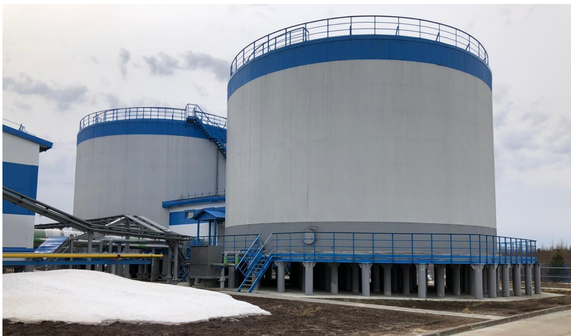
Рисунок 1 – Общий вид резервуаров РВС-3000
