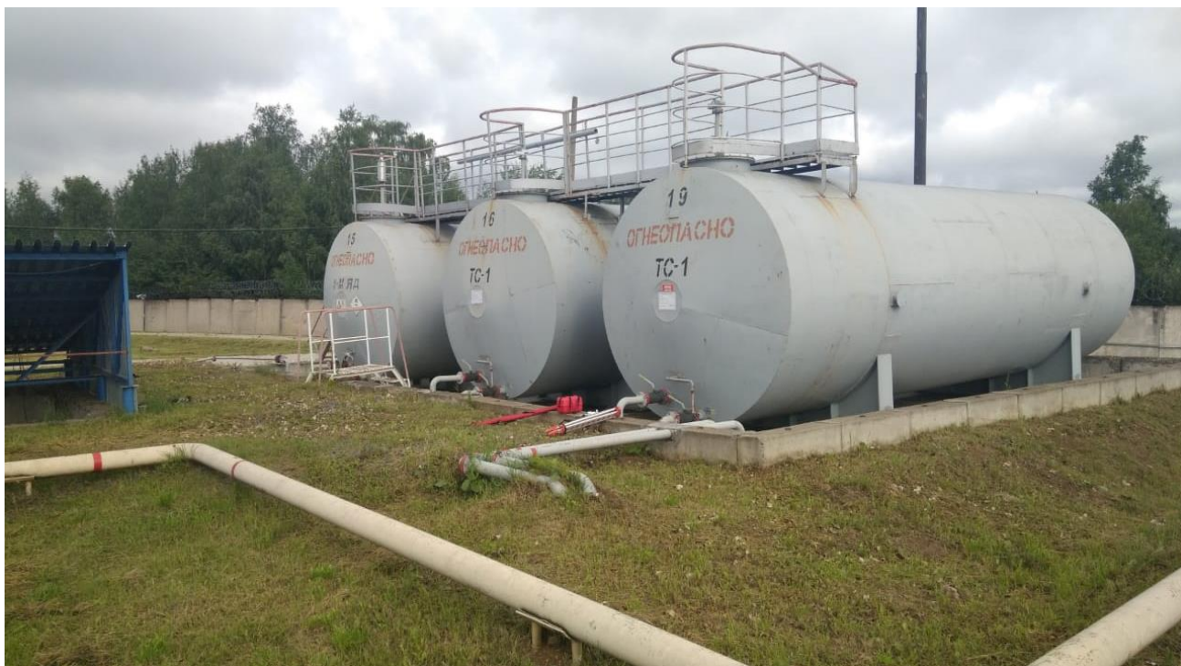
Рисунок 1 – Общий вид резервуаров РГС-75
