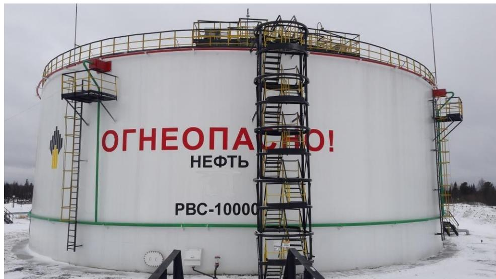
Рисунок 1 – Общий вид резервуара стального вертикального цилиндрического РВС-10000
