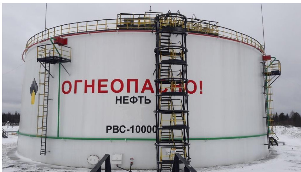
Рисунок 1 – Общий вид резервуаров стальных вертикальных цилиндрических РВС-10000
