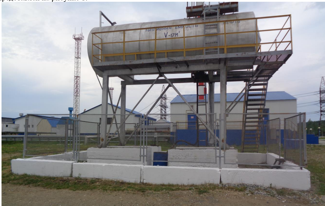
Рисунок 1 – Общий вид резервуара РГС-20
